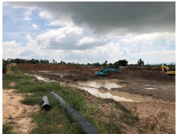
ขณะดำเนินการขุดลอกหนองหลวง
